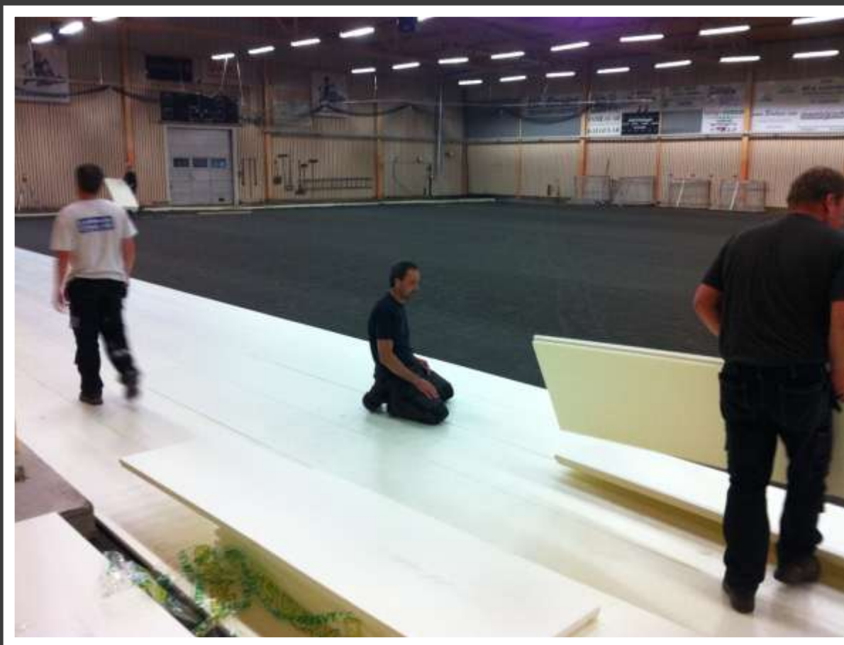
Isoleringsarbete i mitten Holger. 20120816
