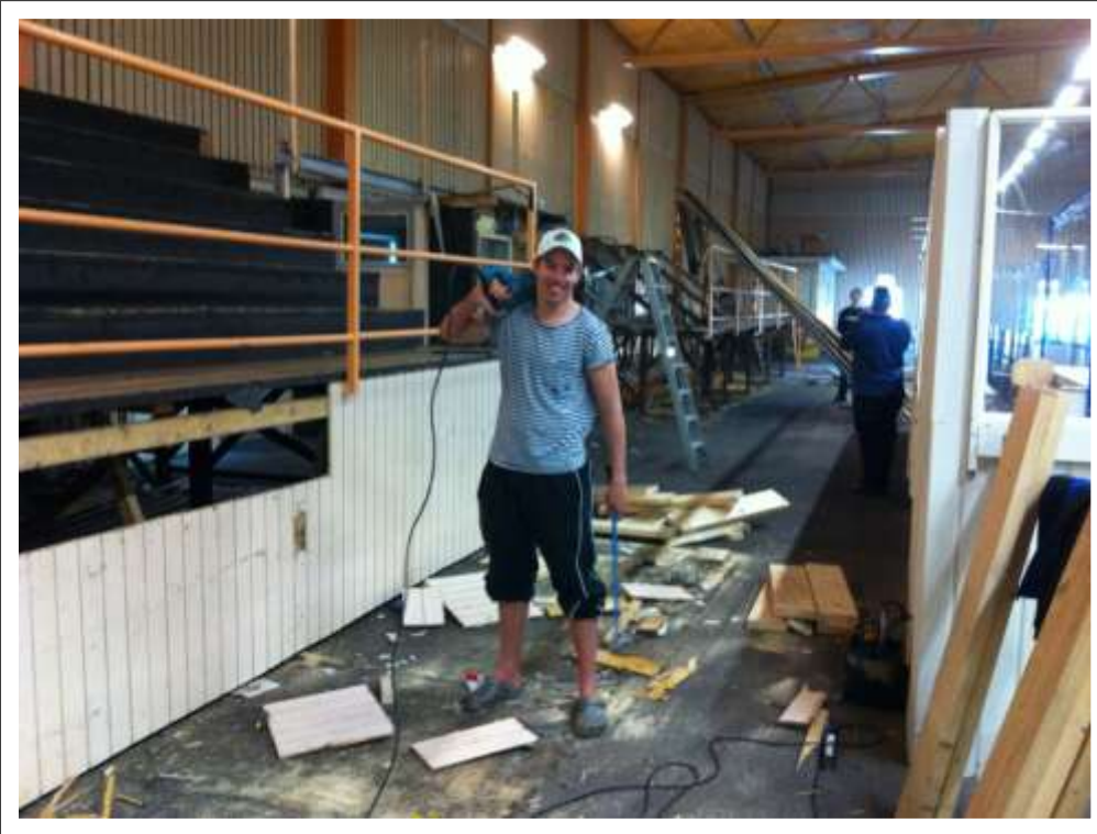
Sommaren 2011 startar rivningen av läktaren. Andreas Håkansson med tigersågen
