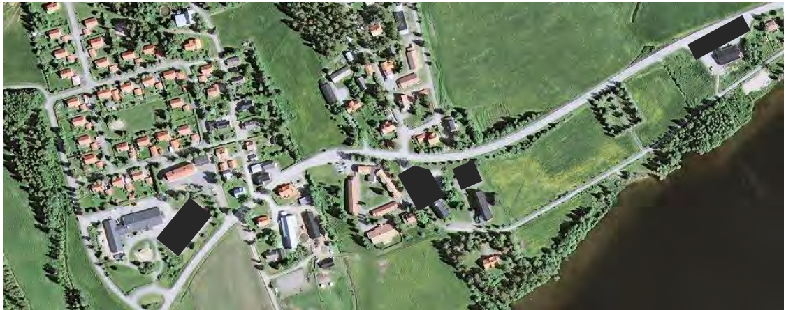
Dagens tre stora öppna ytor i direkt anslutning till Tavelstjövägen .
