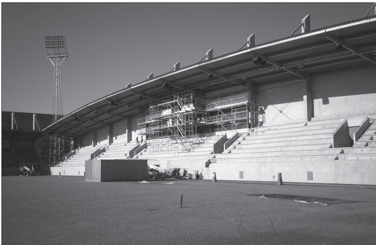
Gavlevallen – Gefle IF:s blivande hemmaarena under uppförande.
