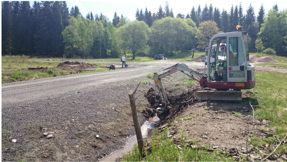
Diket i målsvängen dräneras och läggs igen.
